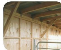
Das Dach ist aus verzinktem Trapezblech (von unten weiß, von oben braun mit einer Platisolbeschichtung)
